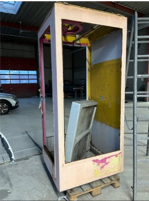
Die ehemals gelbe Telefonzelle FeH 53 mit Einschwenktür nach dem Ausbau der Scheiben, der Kaeder und dem anderen Innenleben.
